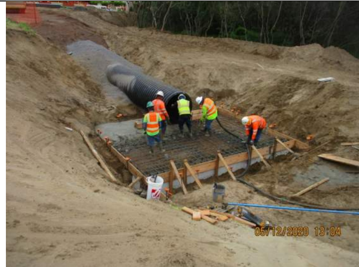
Concrete pour for drainline outlet headwall slab.
